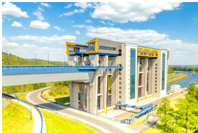
Schiffshebewerk von Niederfinow
