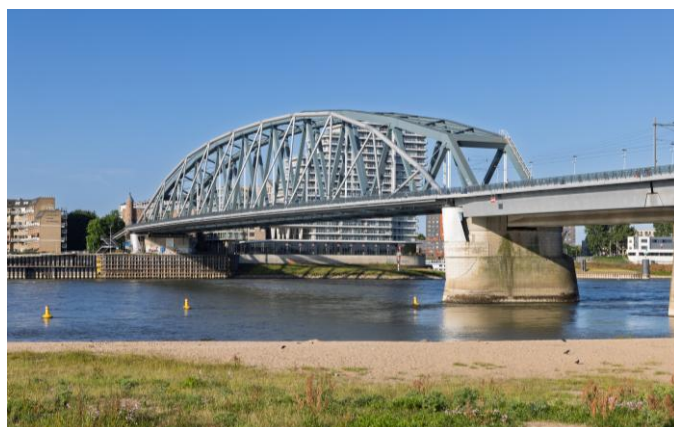
Pont métallique près de Nimègue
