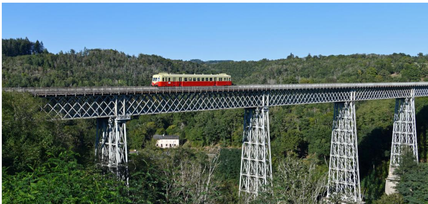
Extrazug auf dem Viadukt von Busseau-sur-Creuse
